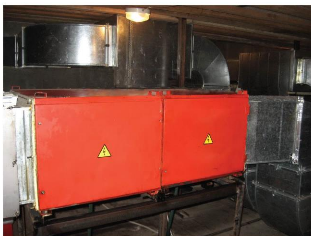
Электростатические фильтры различной производительности в системах МН
